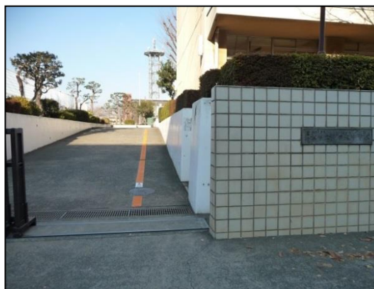
※滝の沢中学校 誘導ライン
