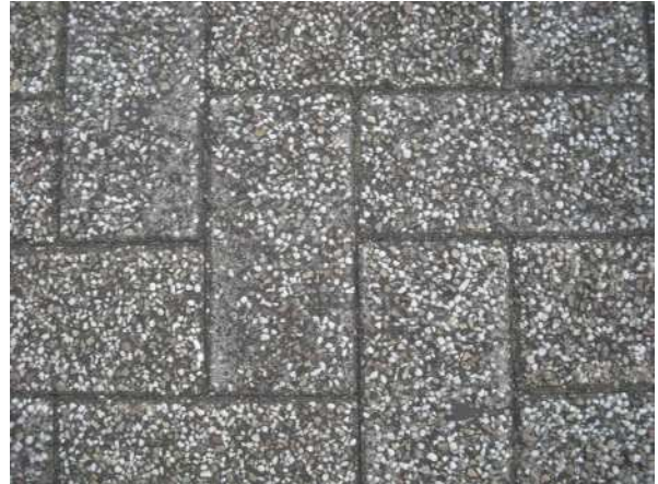
インターロッキングブロック (長後駅東口)
