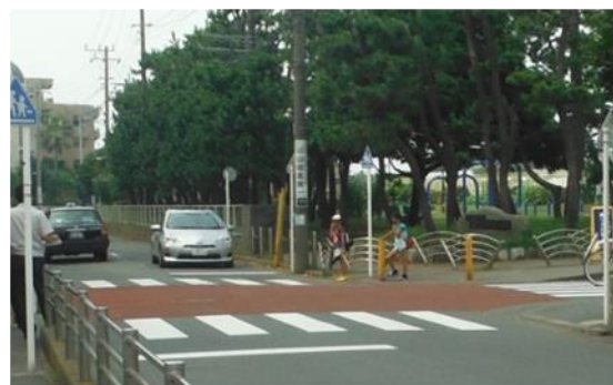
安全対策実施後
