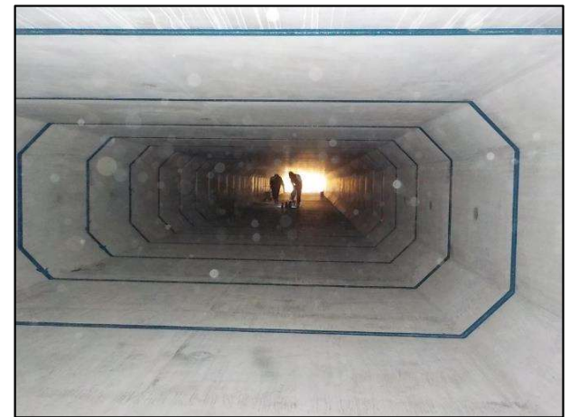
推進工事完成(放流管)
