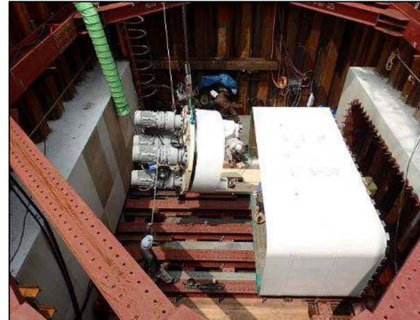
推進機据付中
