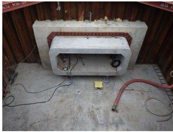
推進工事完了(発進立坑)
