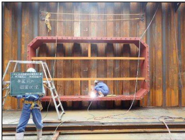
推進機据付前
