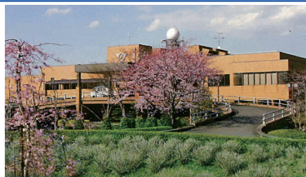
◆ 大清水浄化センター 毎日、約 18 万人分 ※2 の汚水を処理しています ※2 H28 年度末現在の水洗化人口
