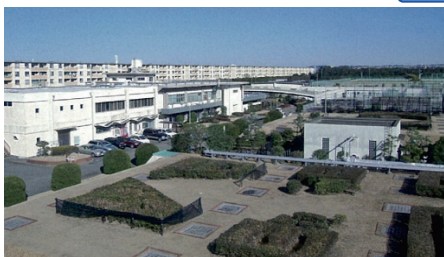
◆ 辻堂浄化センター 毎日、約 21 万人分 ※2 の汚水を処理しています
