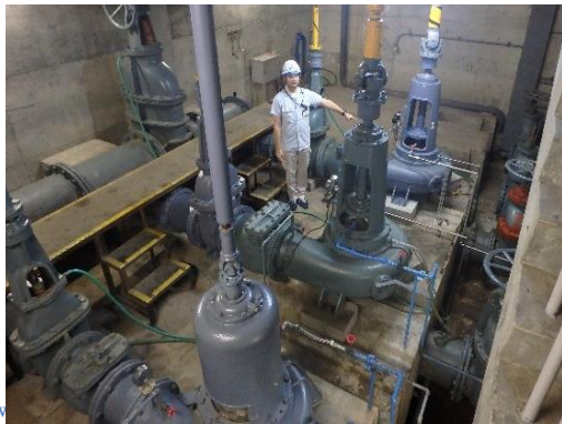
汚水ポンプ改築前
