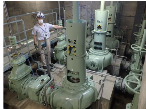
汚水ポンプ改築後
