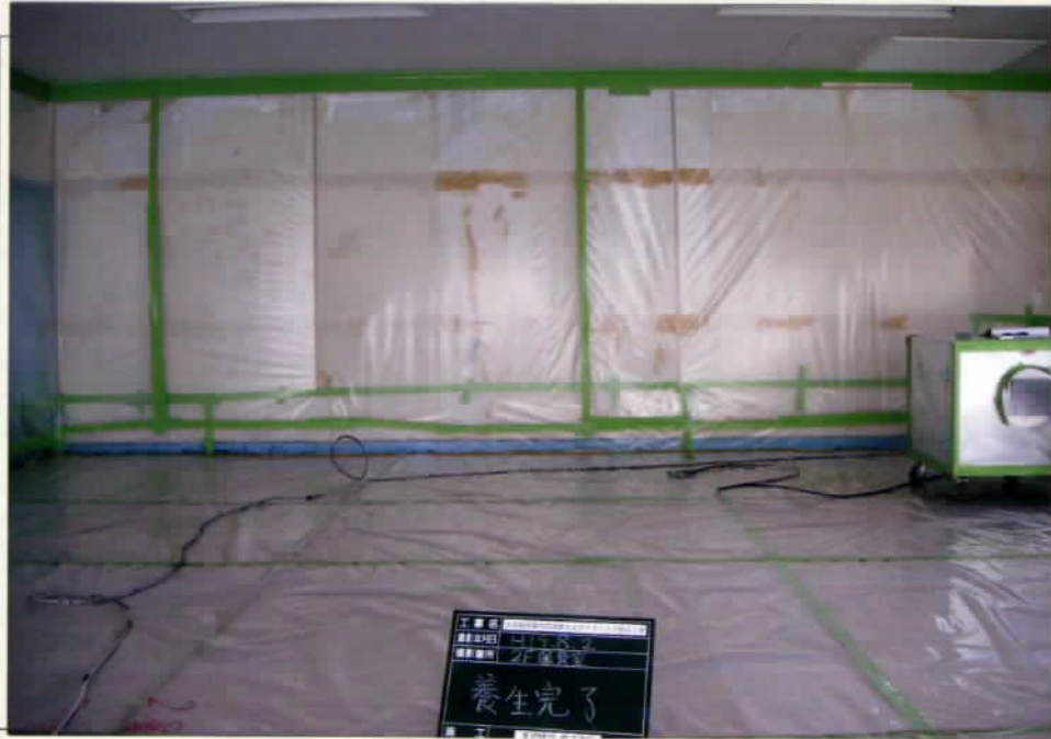
写真4 壁プラスチックシート張り
