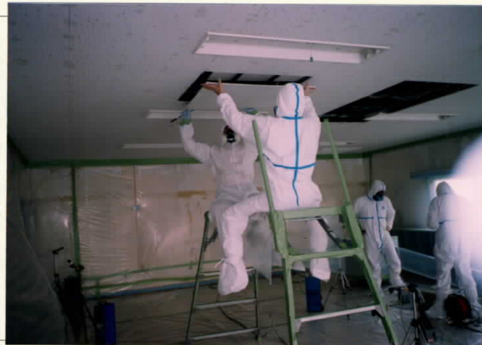
写真5 天井ボード取り外し
