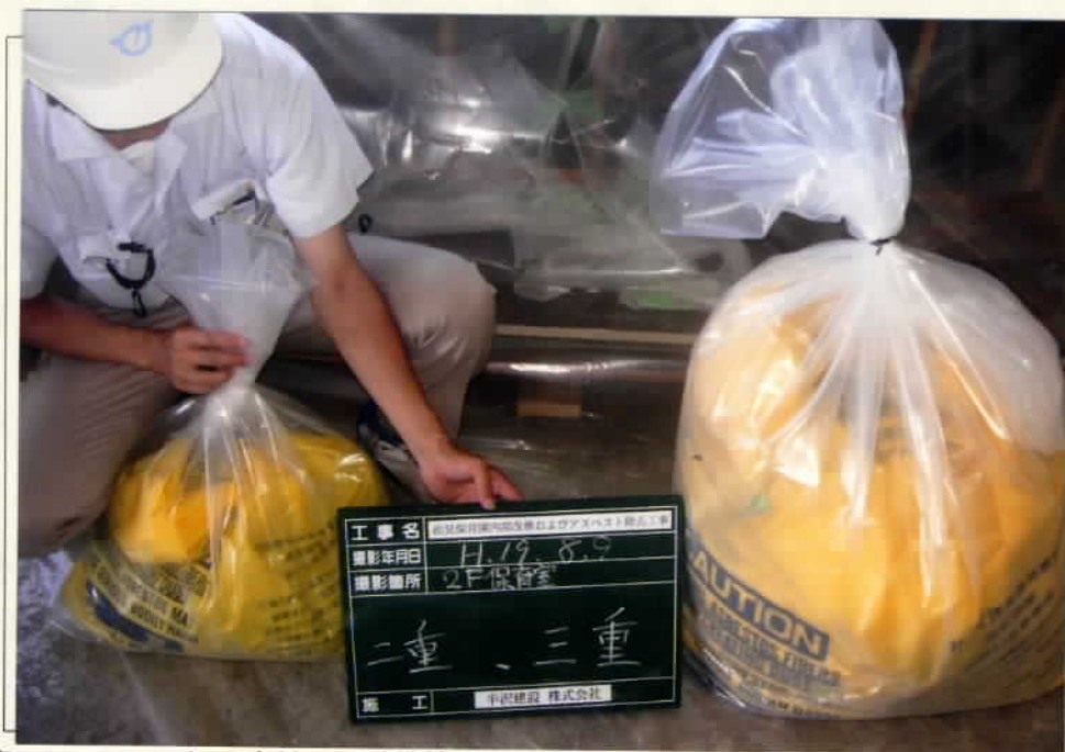
写真7 アスベスト廃材の三重袋詰め
