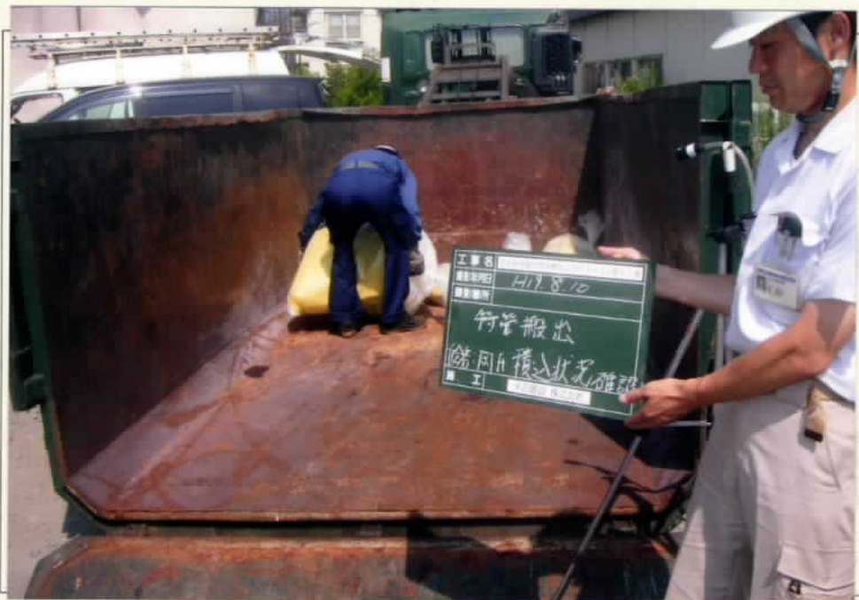
写真8 アスベスト廃材の搬出
