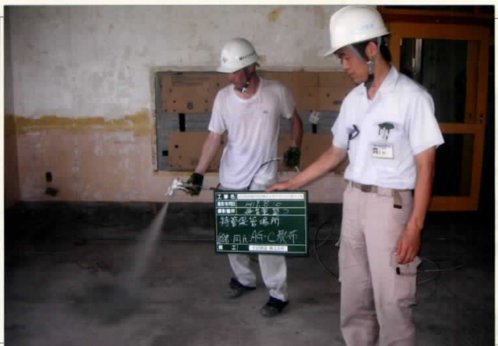
写真9 アスベスト廃材保管場所のクリーニング及びアスベスト凝固剤の吹き付け
