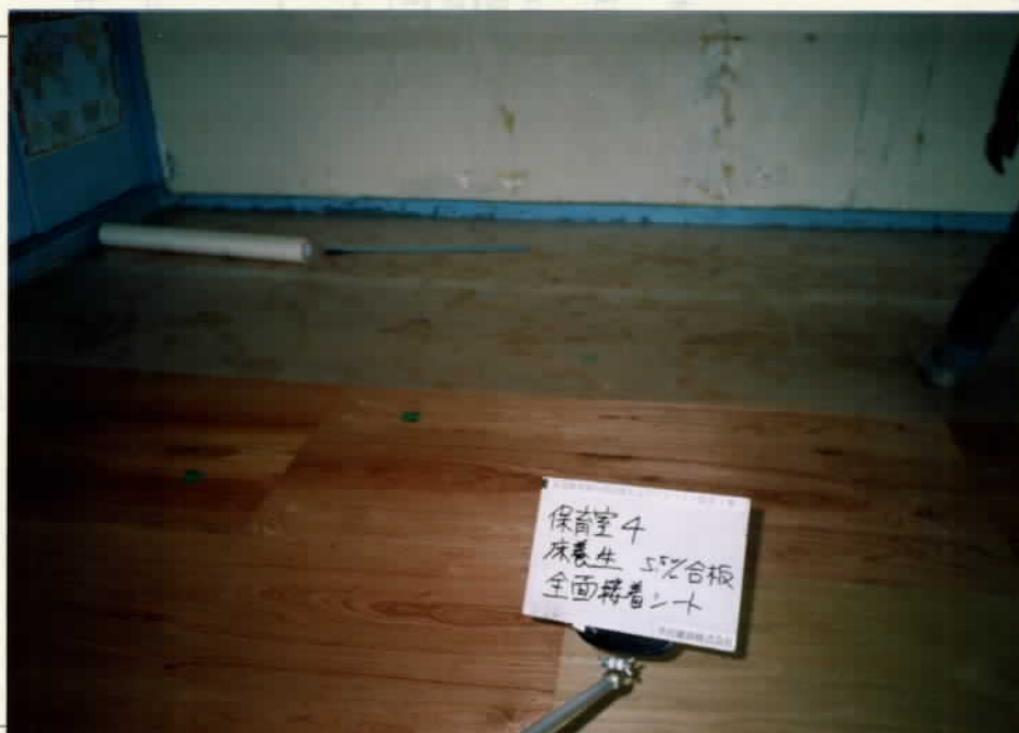
写真2 床全面接着シート貼り
