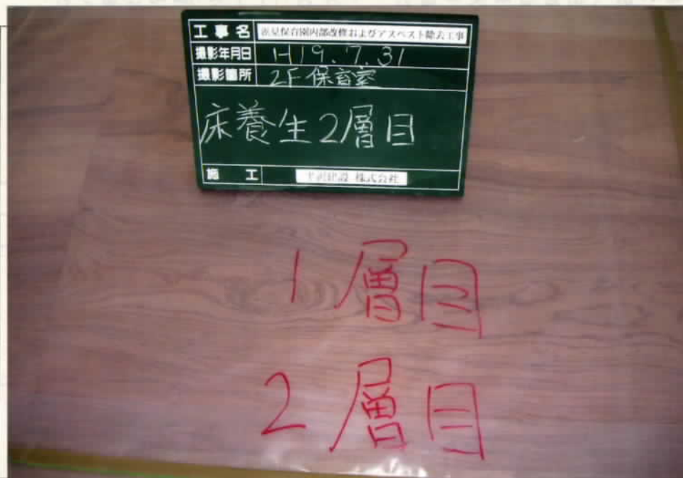
写真3 床プラスチックシート二重貼り
