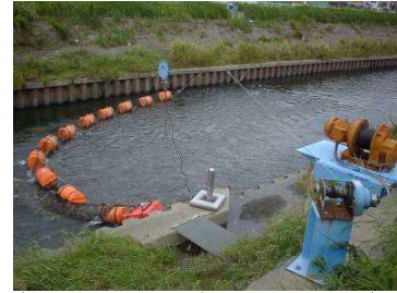
境川除じん機(大清水橋上流)
