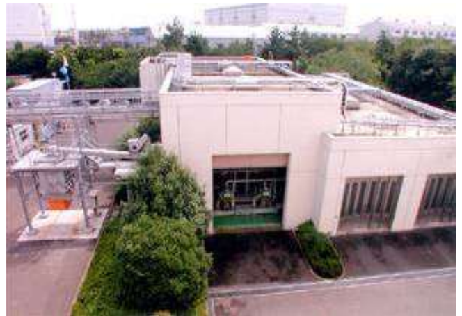
受入棟（前処理施設）
