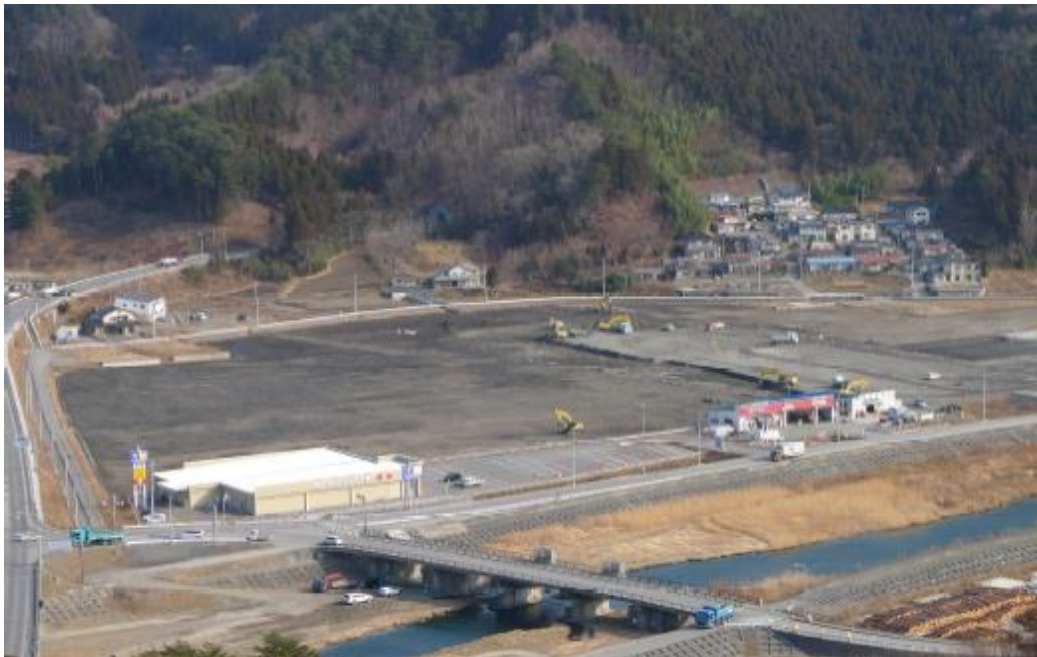
写真 原状復旧後
