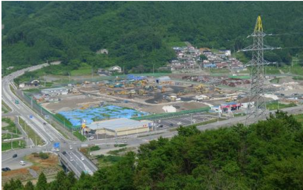
写真 原状復旧前
