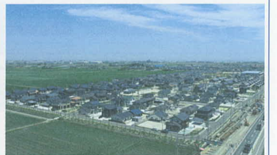
玉浦西地区防災集団移転団地 (岩沼市)
