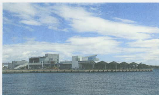
塩釜市魚市場が完成 (塩釜市)
