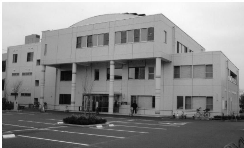
改築された遠藤市民センター
