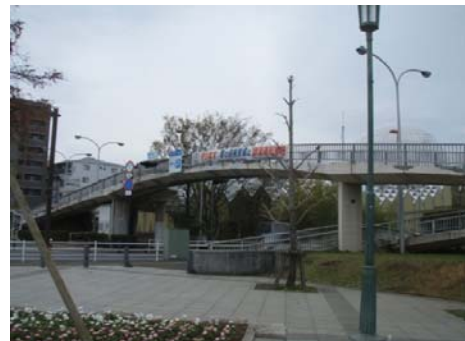
湘南台歩道橋 現況写真
