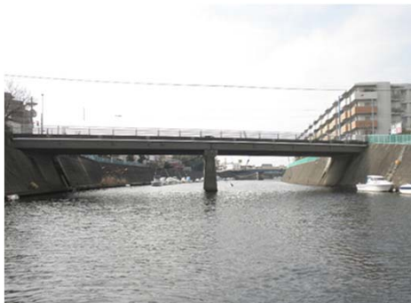
新屋敷橋 現況写真
