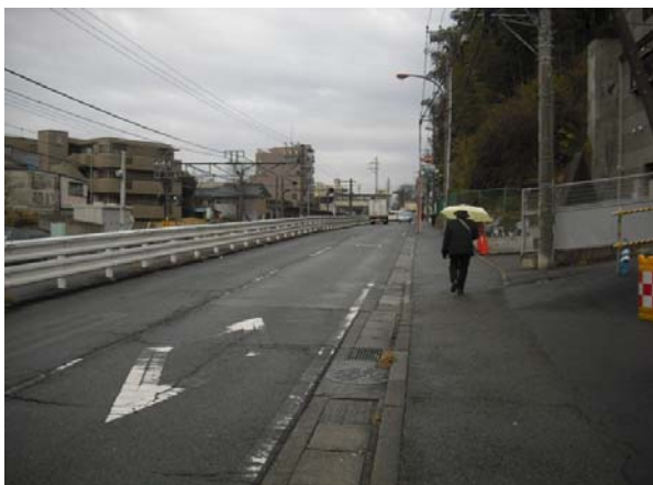
藤沢652号線 現況写真
