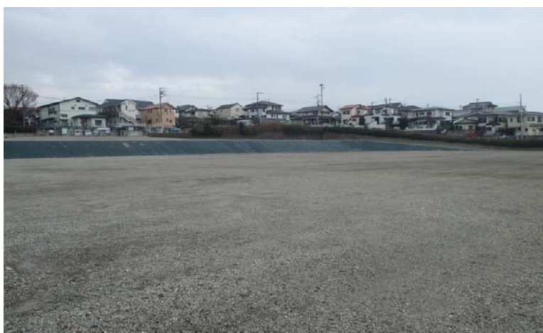
<参考写真>（（仮称）天神スポーツ広場整備予定地）
