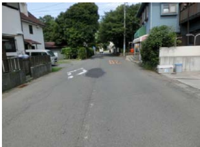
舗装打換工事予定箇所（市道葛原下滝線）
