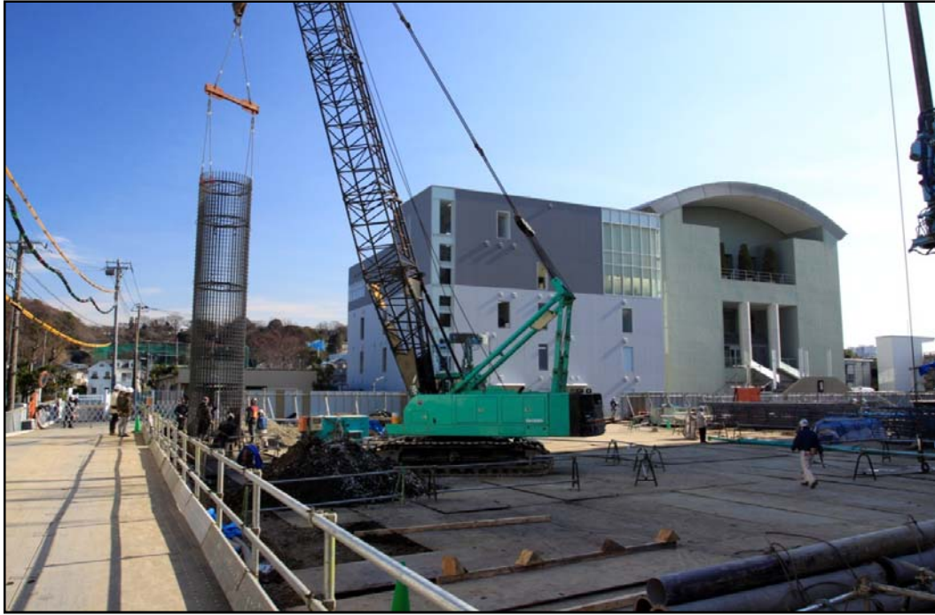
(市民病院再整備事業工事風景)
