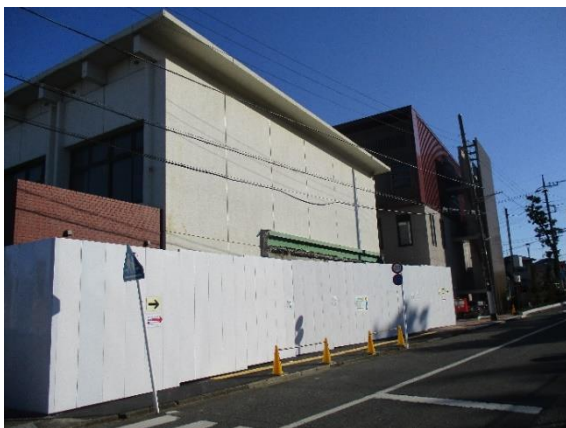
解体予定の旧善行市民センター（手前）
