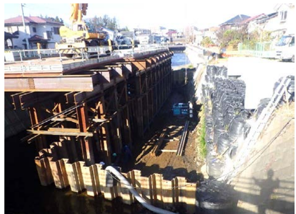
蓼中橋【左岸護岸築造】
