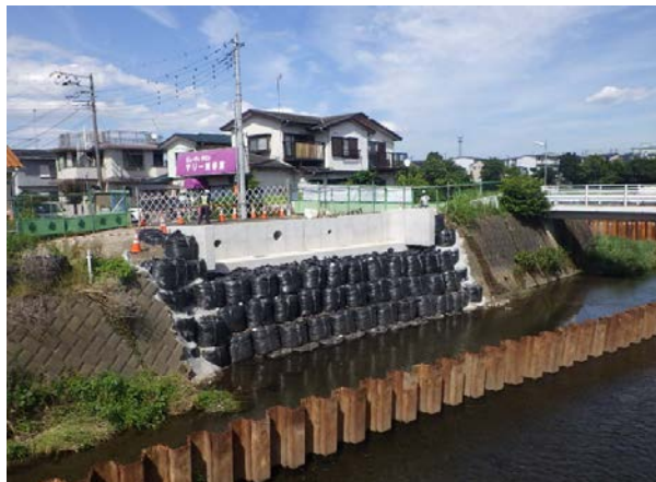
蓼中橋【左岸橋台完成】
