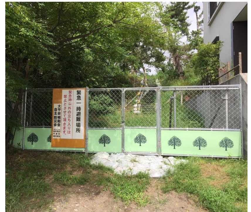
●避難場所入口門扉設置 と土嚢で段差を調整
