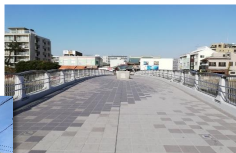
弁天橋の改修 (道路維持課)
