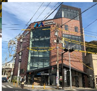
湘南モノレール湘南江の島駅 エレベーター設置への補助 (都市計画課)
