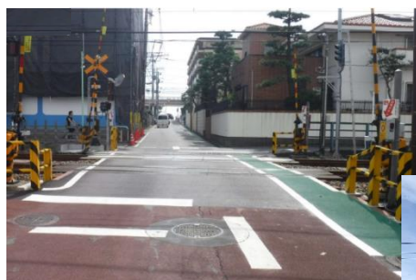
鵜沼海岸 10 号踏切の改良 (道路整備課)
