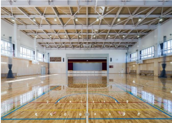
六会中学校屋内運動場(令和元年度完成)
