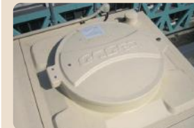
マンホール蓋
