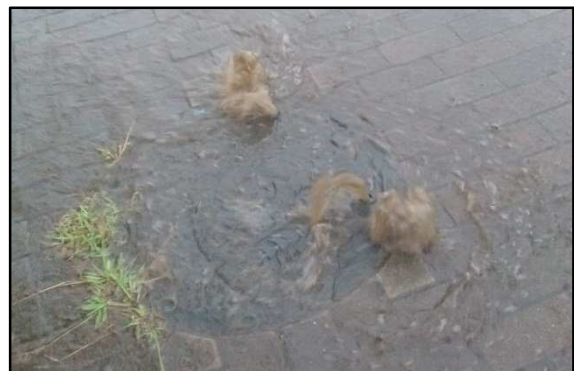
【マンホールからの溢水状況】
