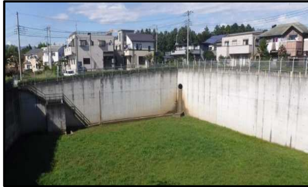
【菖蒲沢境地区調整池】
