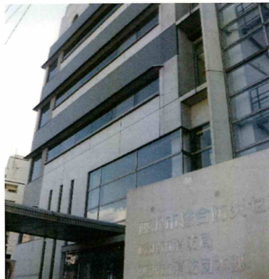
藤沢市防災センター [3-64]
