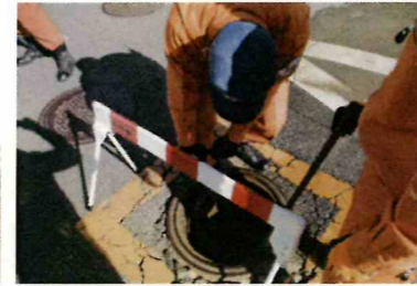
しやうかぜつびてんけん 消火設備点検 [3-3]
