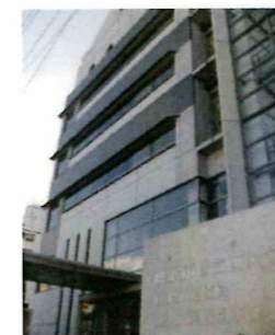
藤沢市防災センター [3-108]
