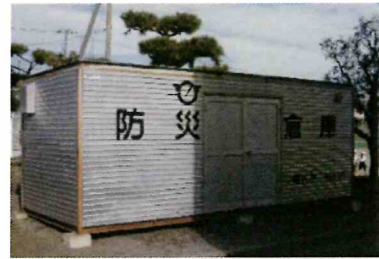
ぼうさいようびちくそうご 防災用備蓄倉庫 [3-1]
