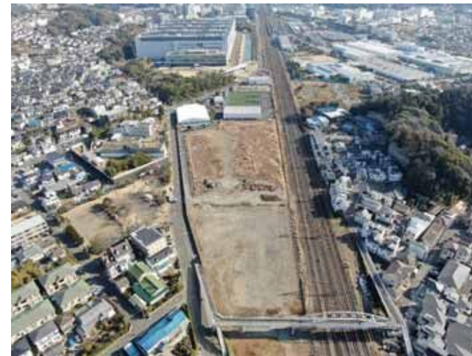
上空から見た村岡新駅周辺地区
