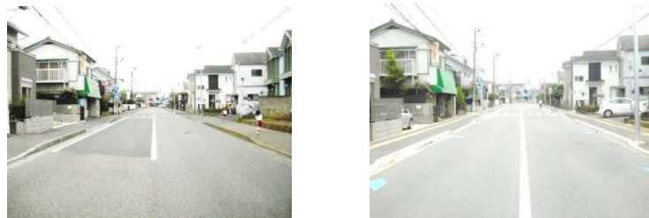
■ 六会駅東口通り線道路改良工事(左:整備前、右:整備後)
