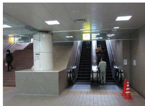
地下道出入り口でのエスカレーター設置によるユニバーサルデザインのイメージ（湘南台駅地下道）
